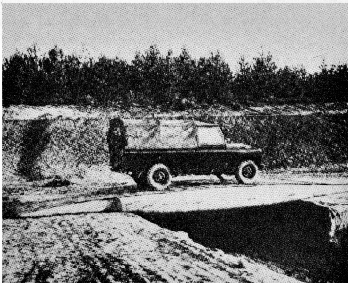
Figura 67. Puente "inflable" de alta presión interna y peso propio de 350 kg.
