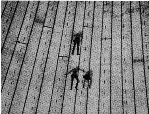
Figura 45. Fotografía desde el interior de la cimbra neumática. Los trabajadores colocan el acero de refuerzo perimetral.
