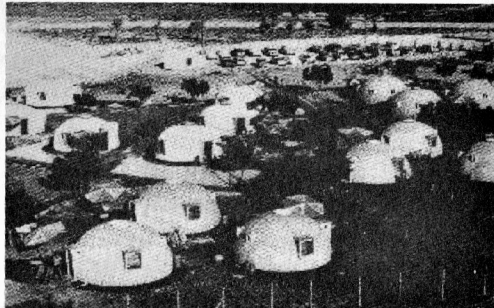
Figura 33. Casas Tipo "Iglú" hechas mediante una cimbra soportada por aire.
