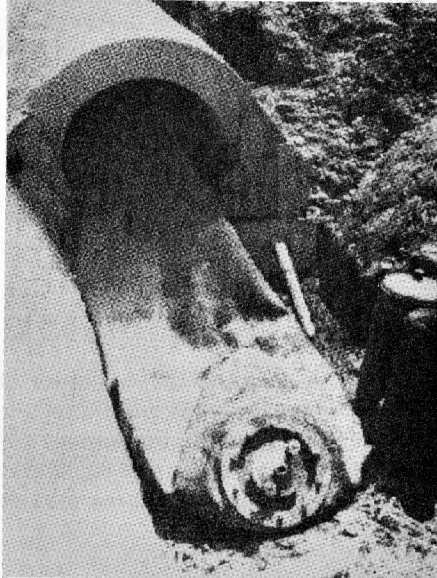
Figura 56. Construcción de ductos in situ utilizando una cimbra neumática.
